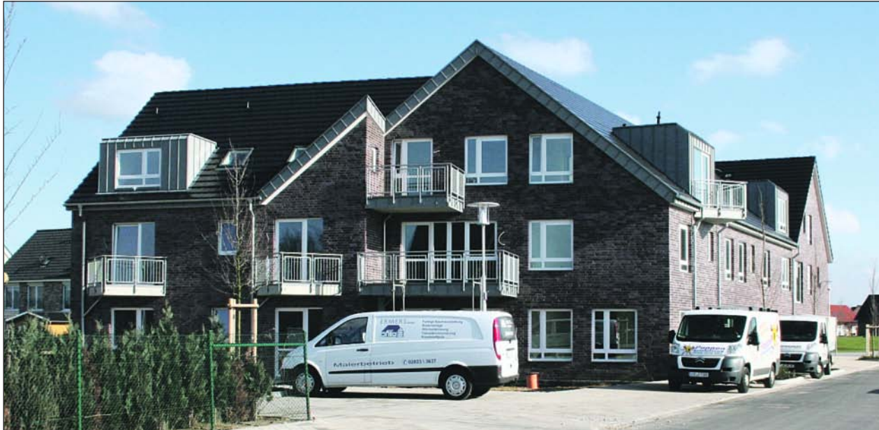
Außen schon fertig, nur innen sind noch die letzten Handwerker.
