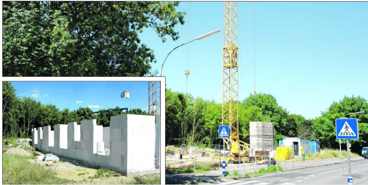
Die Bauarbeiten haben endlich begonnen. Die großen Fensterflächen sind im Rohbau schon erkennbar (kl. Foto). Fotos (2): Moia
