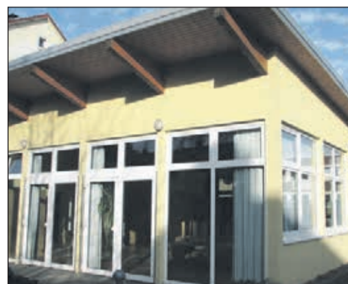
Die umgebaute Mehrzweckhalle Foto: team x
