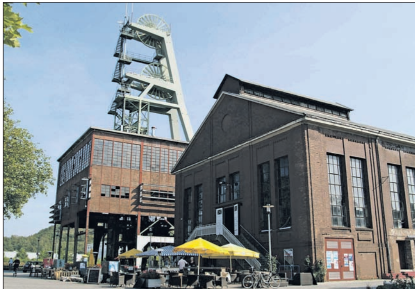
„Die Heizzentrale auf Ewald.“
