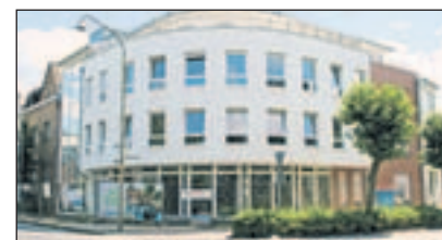
Das Erkelenzer Wohnverbundhaus ist für den Einzug bereit, nur der Bauzaun zeugt noch von den letzten Bauarbeiten.
