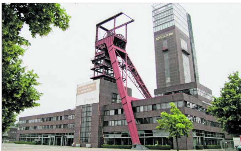
Gut besuchtes Freizeitziel: Zeche Nordstern in Gelsenkirchen. Foto: Neumann
